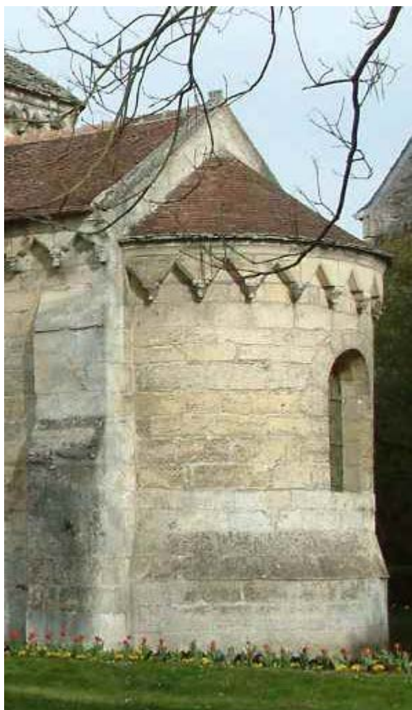
Laon chapelle templière toiture de l'abside - Image Jack Bocar
