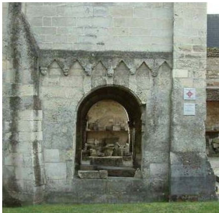
Laon chapelle templière baies en plein cintre - Image Jack Bocar
